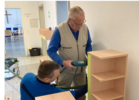
Umbau für Krippengruppe läuft
